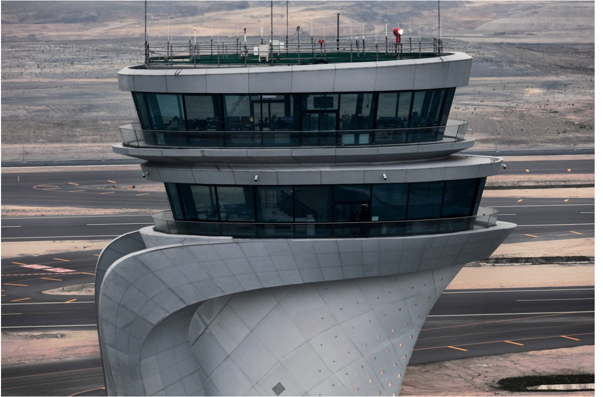
Resim-1.5. İstanbul Havalimanı Kule Görüntüsü (Kaynak; İGA)
